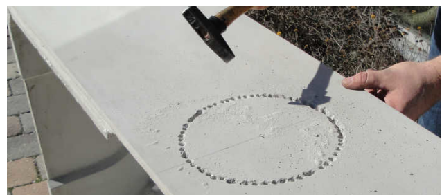
Bild 20: Skära urtag med en bormaskin
