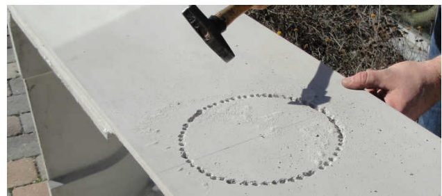
Bild. 19: Perforera konturen med en borr.
