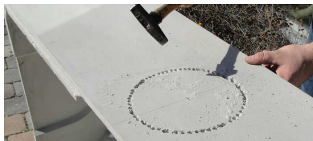
Bild 4: Skära urtag med en bormaskin
